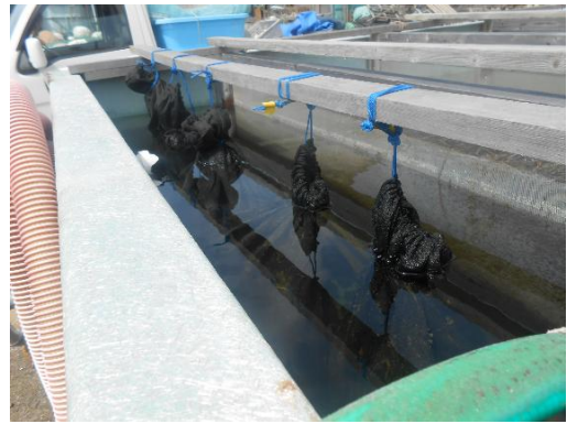
養生袋による水中養生
