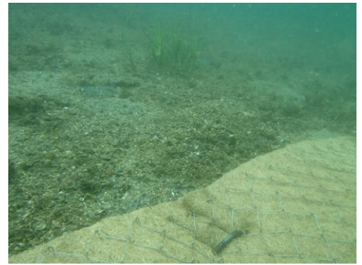
写真-3.14 敷設した播種シート
