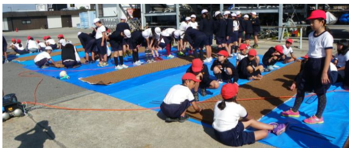
写真-2.5 ヤマトを重ね反転し菱形金網を被せ一体化
