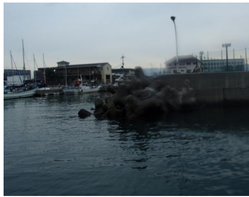
写真-3.7 敷設海域(田尻)
