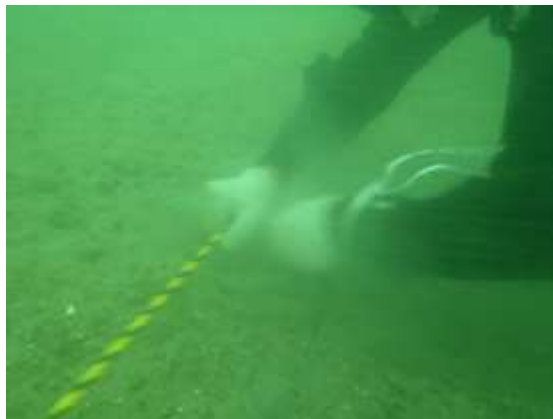
トラロープでの丁張り
