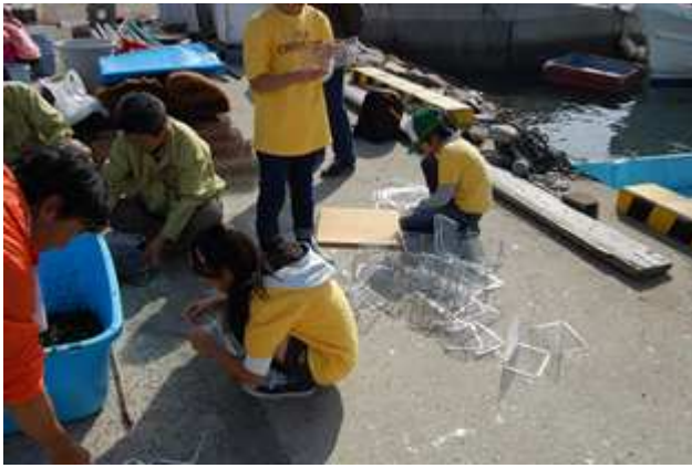
分業？金網を板を使って直角に折り曲げ
