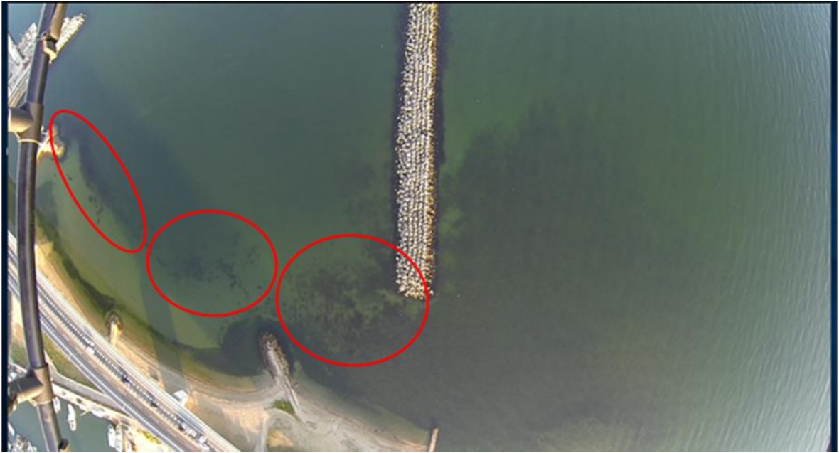
岡田浦 1・陸側から
