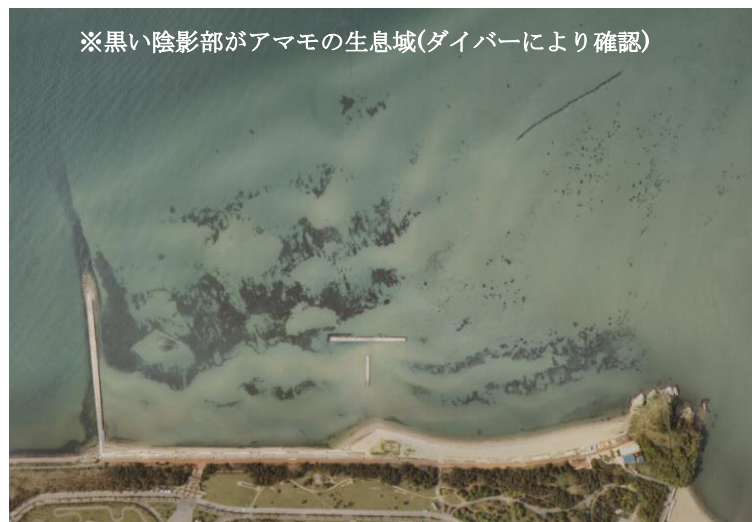
写真-2.1 赤穂海浜公園前の空撮映像 (H18.12)
