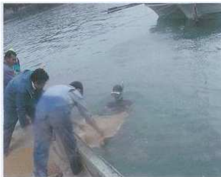
写真 アマモマットの設置状況
