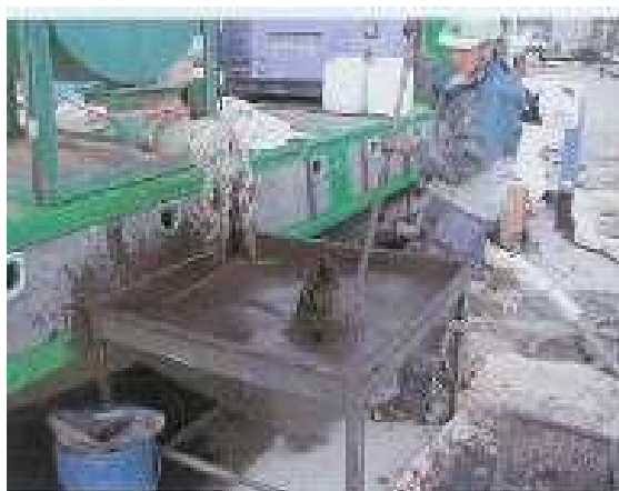
写真 注入材料の攪拌
