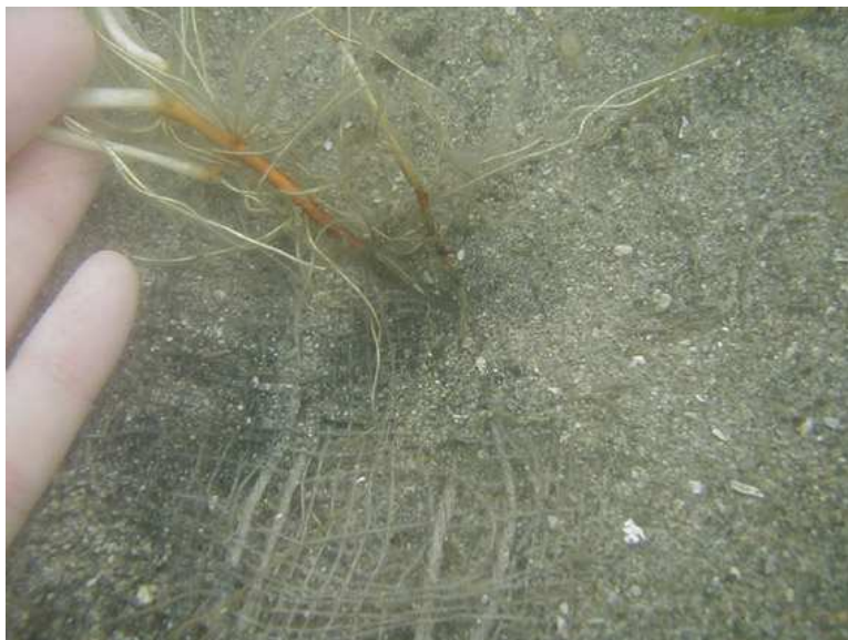
アマモマットの腐食状況
